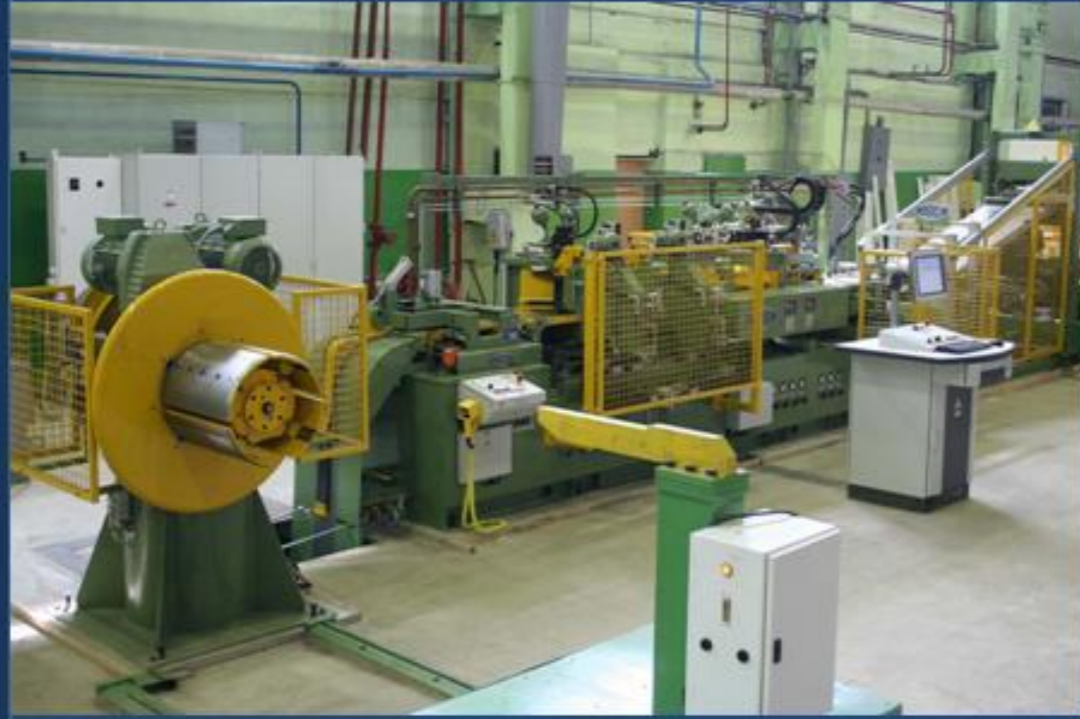
Автоматизированная линия поперечного раскроя электротехнической стали производства фирмы «Georg», Германия
