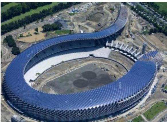
Изюминка тайваньского сооружения в том, что стадион облицован панелями солнечных батарей. Помимо того, что благодаря такому покрытию здание выглядит весьма необычно, батареи, по замыслу разработчиков проекта, должны запастись до 1,4 гигаواتт-часов энергии в год. Расходовать энергию планируется как на нужды стадиона при проведении спортивных соревнований, так и на рядовых потребителей, если появятся излишки или в программе стадиона возникнет перерыв.
