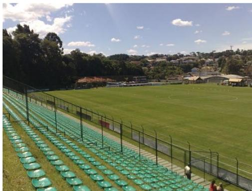
Стадион прославился тем, что построен без использования бетона, только из экологически чистых материалов. Сиденья для зрителей здесь врезаны в склон холма, а между ярусами растет трава. Строительные конструкции лестницы, перила, ограждения выполнены из дерева. Стадион вмещает лишь 6000 зрителей, чаще всего здесь проводятся матчи клуба «Коринтианс Паранаэнсе».
