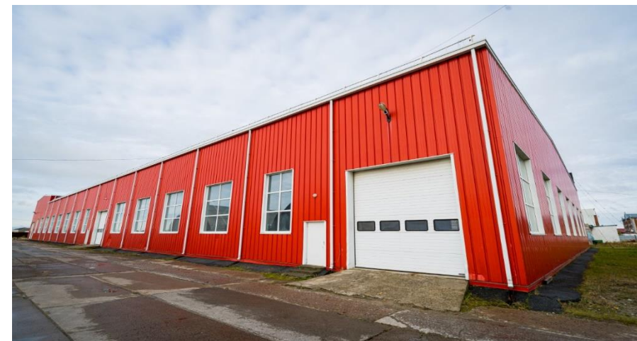
Действующий производственный корпус промышленного технопарка
