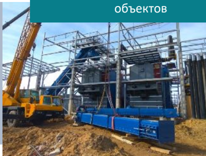
Строительство энергетических объектов
