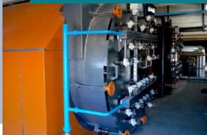
Производство котлов на биомассе
