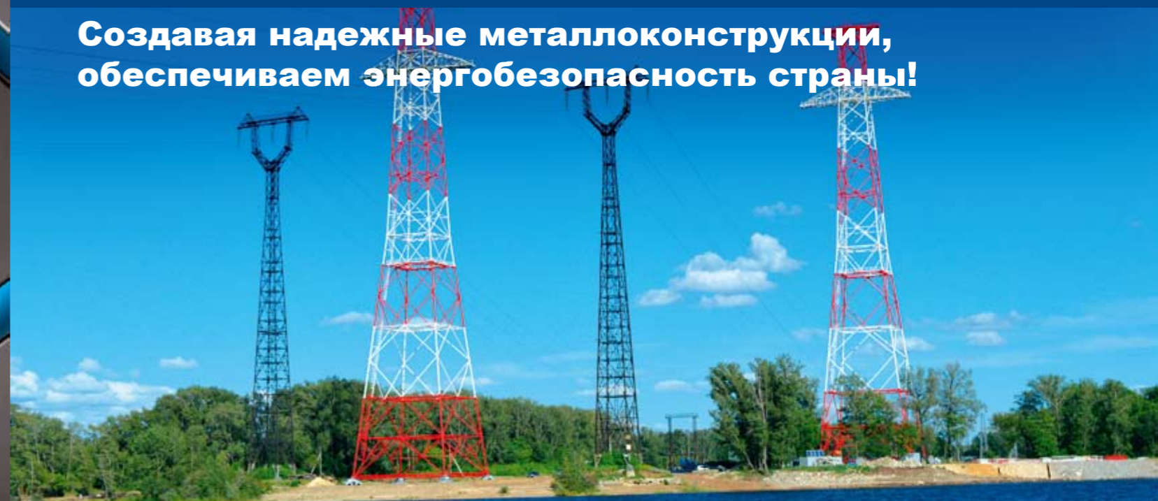
Проект «Реконструкция спецперехода ВЛ 220 кВ Балаково через реку Волга». Металлические трубные опоры АТ-96,87, производитель ЗАО «Завод ЭСКОН», заказчик ПАО «ФСК ЕЭС», 2016-2017 гг.
